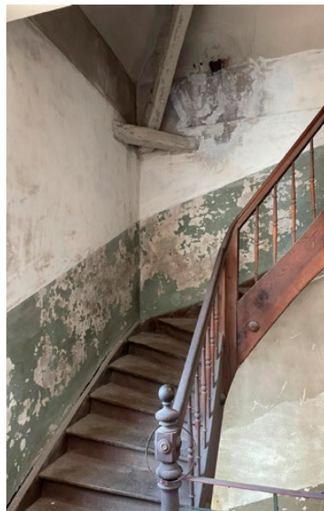
L'ancienne usine de la place de la gare à Vendlincourt, promise à un bel avenir.
